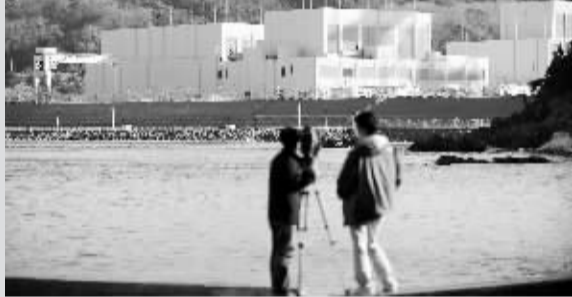
▲日本另两座核电站乏燃料池一度失去冷却功能。4月5日,在日本宫城县女川町,摄影记者在拍摄女川核电站。日本经济产业省原子能安全保安院8日宣布,由于7日夜的里氏7.1级余震,东北电力公司的女川核电站和东通核电站的乏燃料池在地震后曾短暂丧失冷却功能,但很快得到恢复,乏燃料池水温几乎没有上升。本文配图均为新华社发
