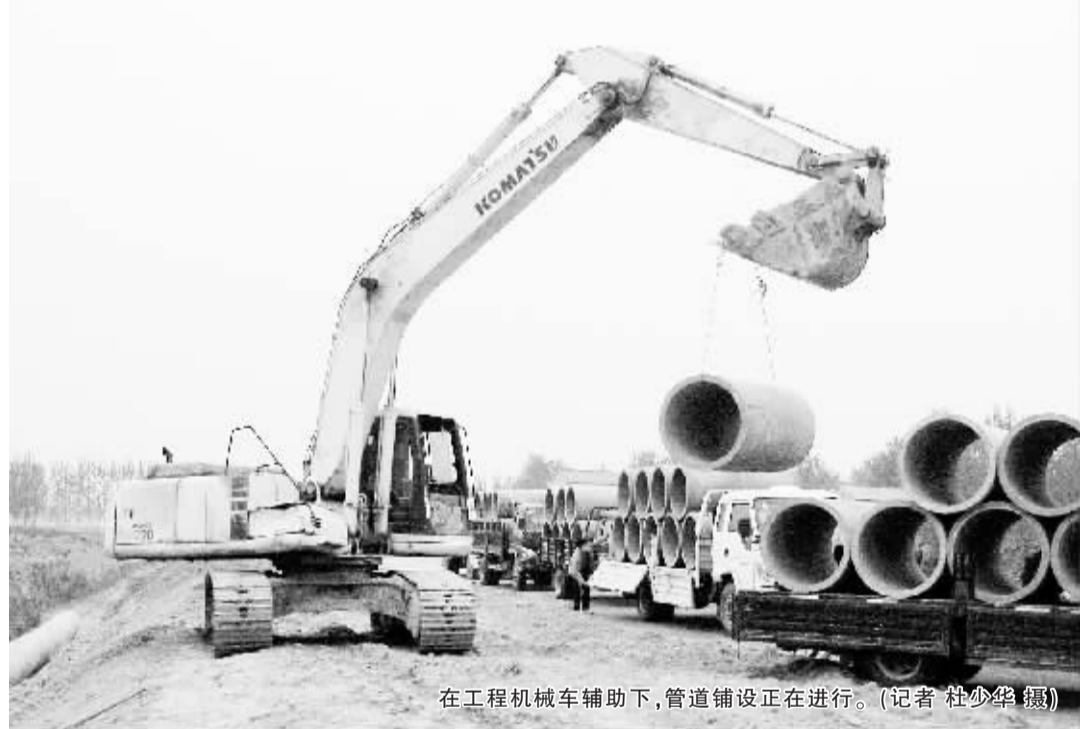
在工程机械车辅助下,管道铺设正在进行。(记者 杜少华 摄)
