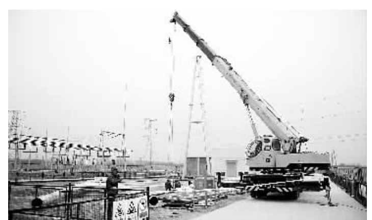
为进一步完善周电网网架结构,解决周边电源点紧张、供电能力不足的问题,周口500千伏变电站二期工程正在加班加点地进行,该工程计划于今年6月底建成投运。图为4月26日,该工程施工现场情景。(魏树林 摄)
