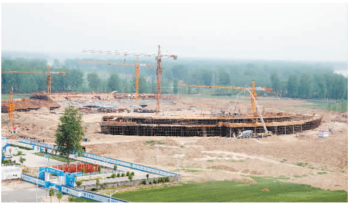
近年来,我市不断加快体育事业发展步伐,使体育事业取得了长足进步。目前,位于东新区的市体育场建设项目进展顺利,项目建成后,我市将结束没有大型综合体育设施的历史。(记者 王映 摄)
