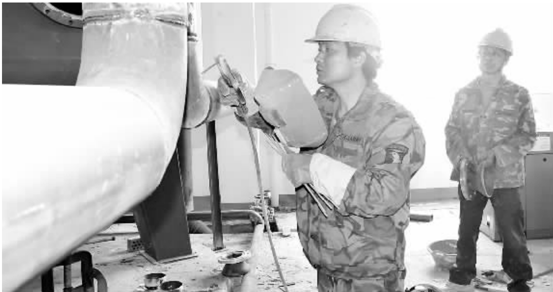
昨日,两名工人在扶沟县产业集聚区污水处理厂一期工程规范操作。该县为了进一步提高产业园区的承载力和吸纳能力,打造环保型产业集聚区,投资兴建了集聚区污水处理厂和中水回用项目,预计日处理污水3万吨。(记者 沈湛 摄)
