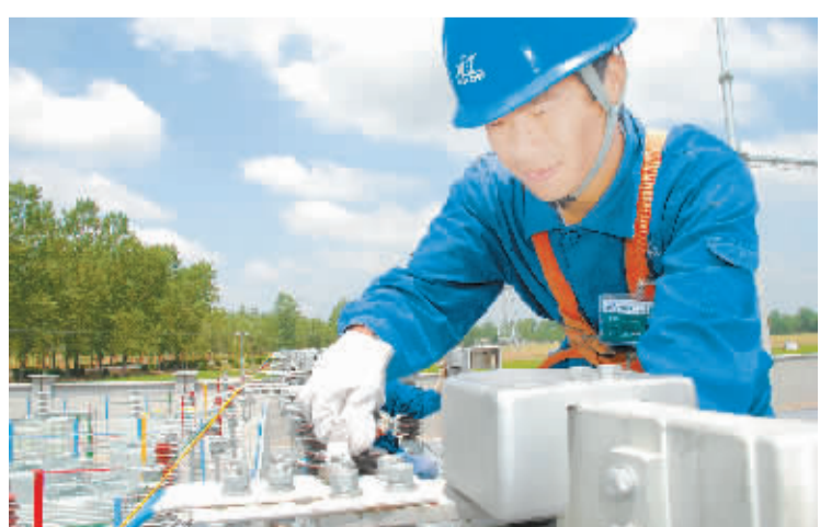
周口市重点建设项目之一, 投资 1.349 亿元的沈丘周营 220 千伏变电站工程进入电气安装调试阶段, 施工人员加班加点加紧施工。图为工作人员在安装站内 35 千伏电容器隔离开关。(赵腾明 摄)
