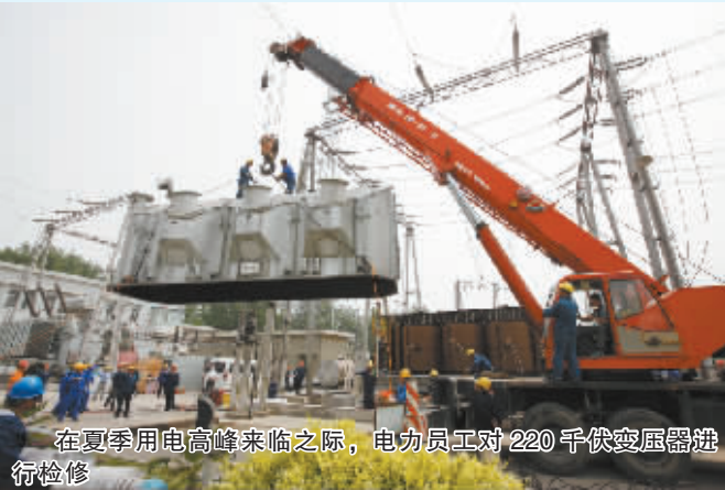
在夏季用电高峰来临之际,电力员工对220千伏变压器进行检修
