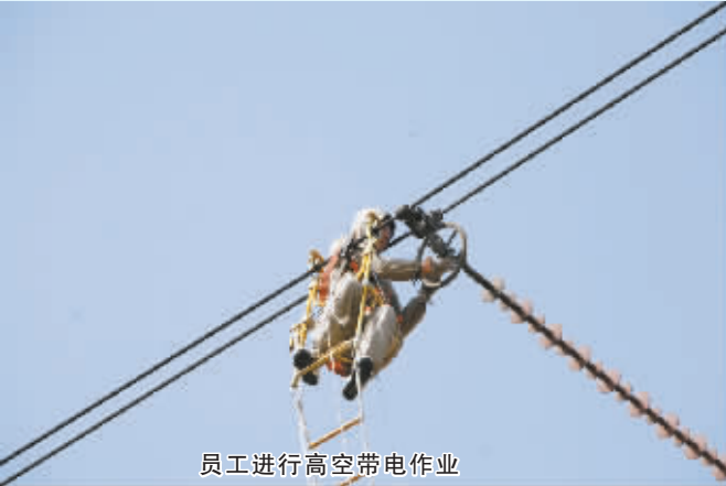
员工进行高空带电作业
