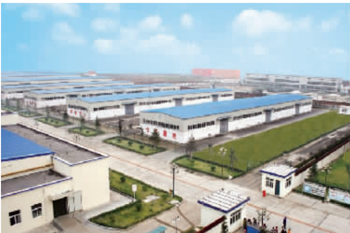
扶沟县产业集聚区中的标准化厂房。
