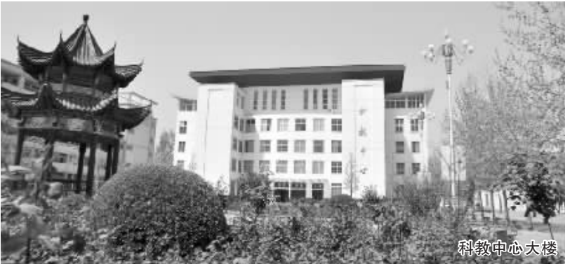
科教中心大楼
