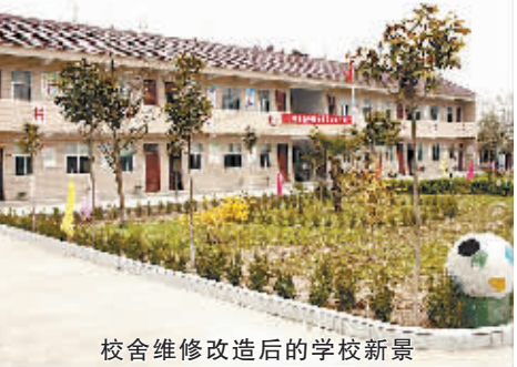
校舍维修改造后的学校新景
