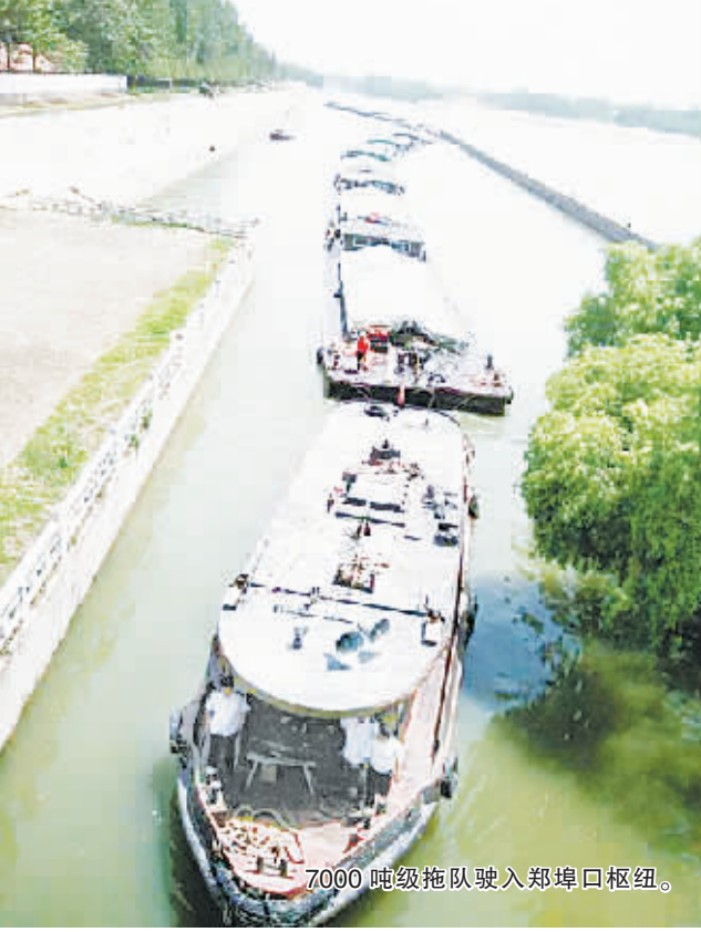
涡河航运工程全面开工。
