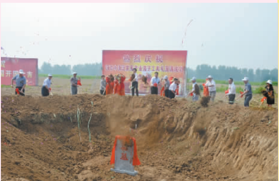
嘉宾为产业园开工奠基
