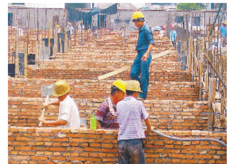
在商水县平店乡刘营村投资 1200 万元的“房地产进乡镇”项目工地上,几名工人挥汗如雨地忙着垒墙、浇灌和测量。该县切实把招商引资项目建设作为发展县域经济的总抓手,今年以来已引资 1.4 亿元,实施各类项目工程 20 多个。(赵永昌 摄)
