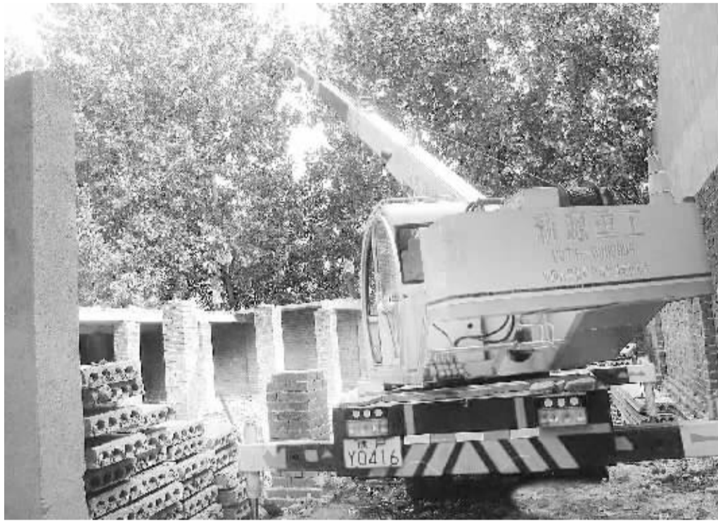
拆除违章建筑
