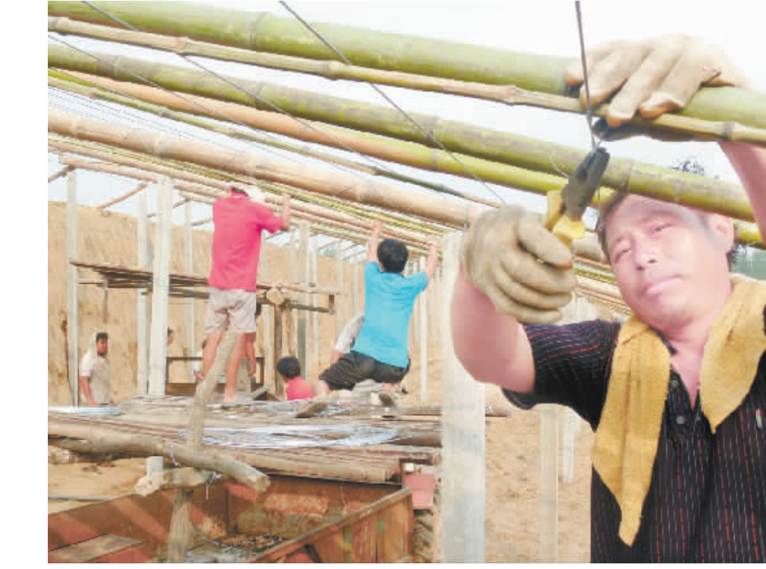
省政府办公厅《关于扩大蔬菜出口加快蔬菜产业发展的指导意见》的出台,切实激发了扶沟县干部和菜农发展蔬菜的热情。目前,该县规划和正在建设200亩以上的蔬菜园区达15个。图为练寺镇秦沟行政村村民正在为日光温室大棚覆盖塑料薄膜。(谷志方 摄)
