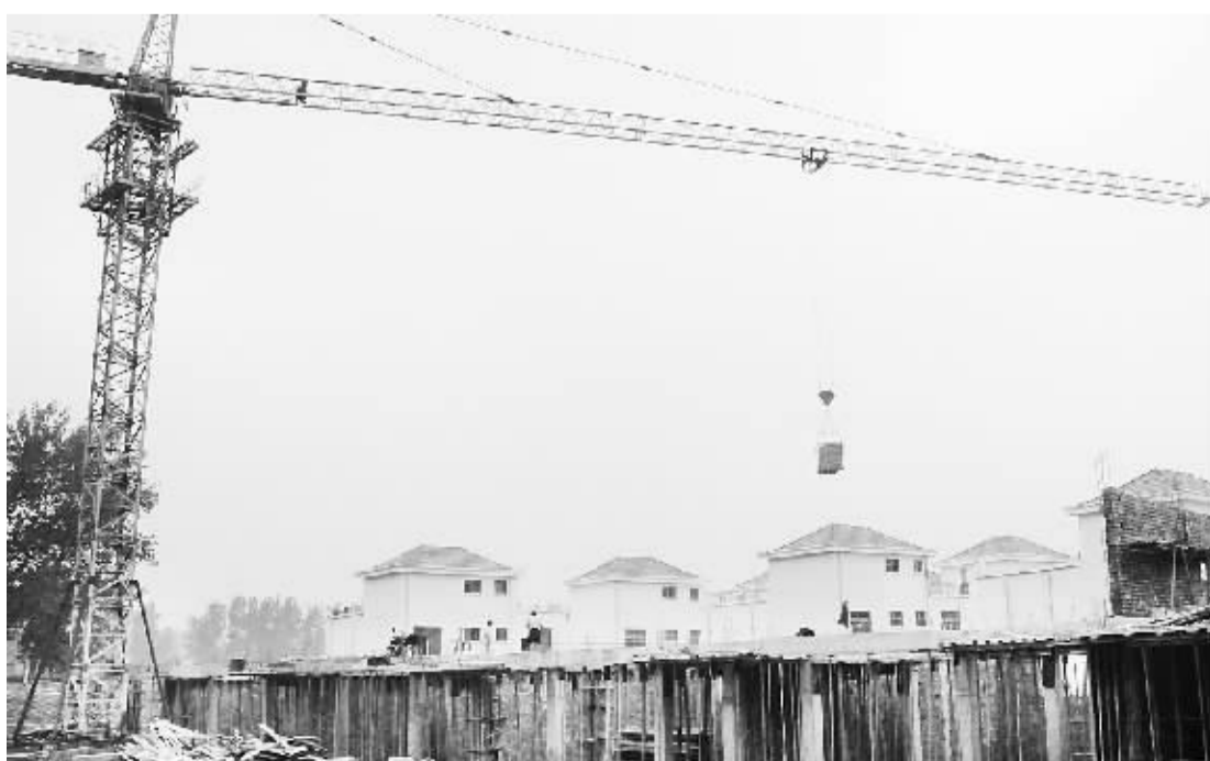
近年来,我市各地围绕“发展新产业、建设新农村、树立新风尚、培育新农民、创建新机制”的要求,在新农村建设方面做了积极有益的探索,取得了明显的进步和成效。图为商水县黄寨镇刘井和谐社区施工现场。(记者 李寒 摄)
