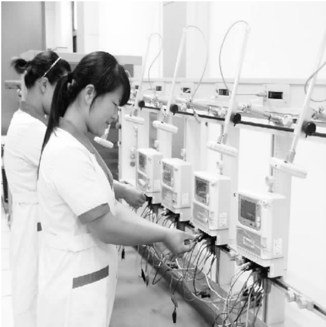
为进一步加强农电系统标准化管理,加强台区电表抄收的定时性、准确性,扶沟县供电公司配电台区安装了智能远抄系统。图为该公司计量员工在校验智能电表。(袁红梅 摄)
