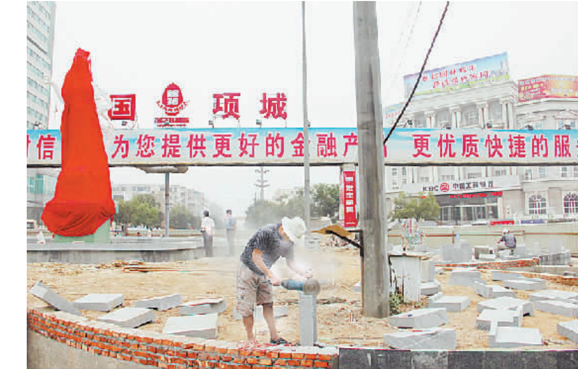
近年来,项城市政府从提高城市品位入手,注重城市内涵人文建设,努力打造宜居城市,受到了市民的一致好评。图为正在紧张施工中的“莲花仙子”塑像。(赵献伟 摄)
