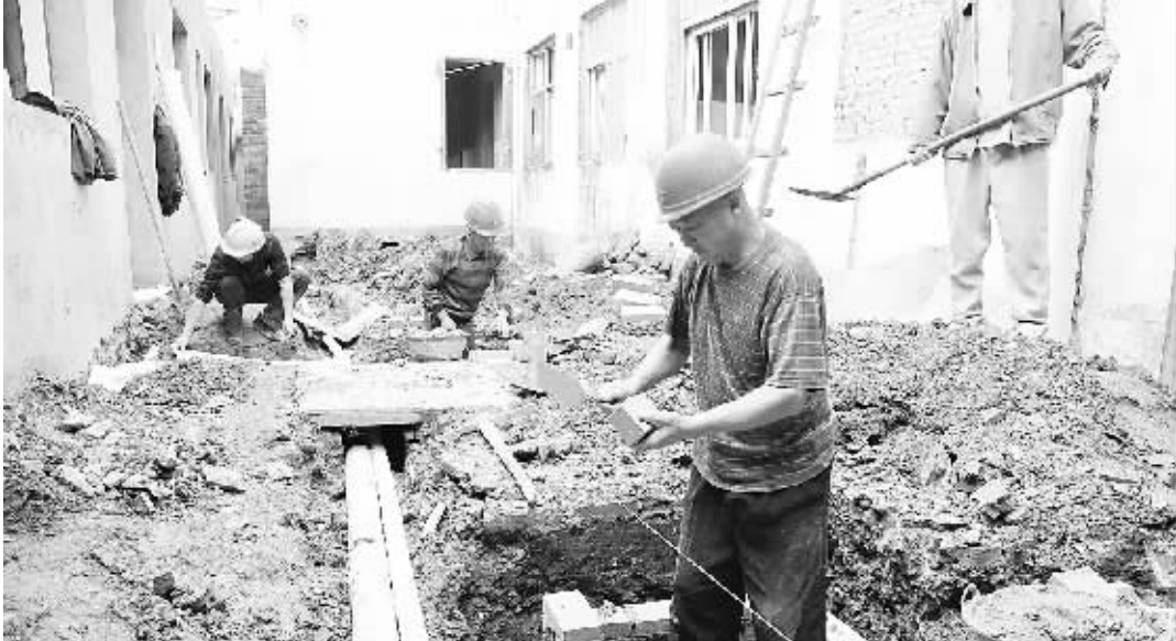
陈州社区卫生服务中心综合楼改扩建项目总投资 240 万元,改扩建面积 2300 平方米。截至目前,改建工程已完成 60%,新建工程主体已完工。图为工作人员在建设排水系统。樊葩茜 李士魁 孔鑫 摄
