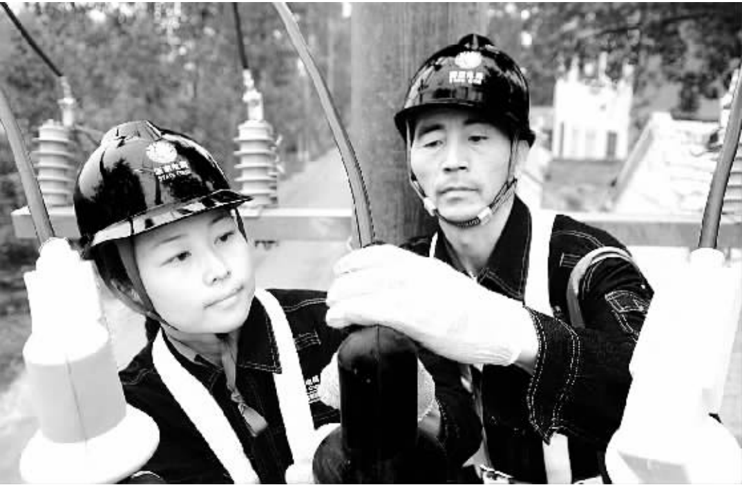
9月19日，县电业局两名职工正在维护电力设施，确保客户正常用电。(刘兴刚 摄)
