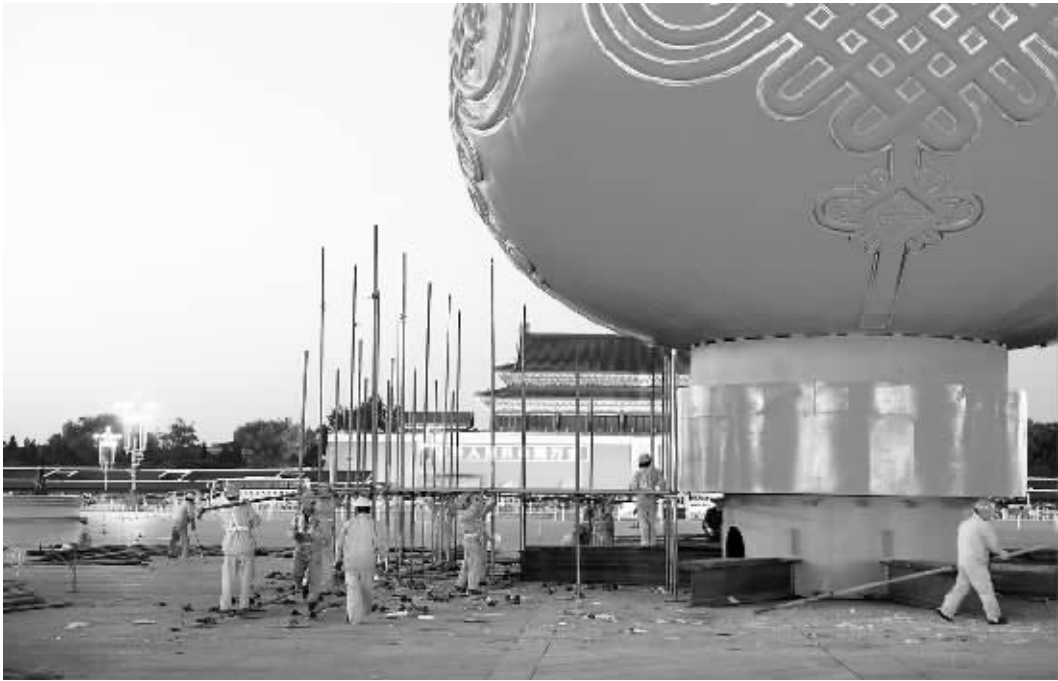
国庆大红灯笼“点亮”天安门广场 9月21日傍晚,北京城建集团工人在为天安门广场国庆拆除脚手架。9月22日清晨,天安门广场国庆“祝福祖国”大型立体花坛的主景大红灯笼安装完成并试灯。新华社发
