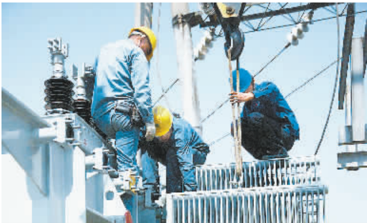
周口供电公司利用当前用电负荷相对偏低的有利时机,组织专业人员对供电设备进行拉网式的检修维护,力保全市冬季安全用电有序供应。图为该公司员工正在太康 110 千伏变电站施工。(魏树林 李露 摄)
