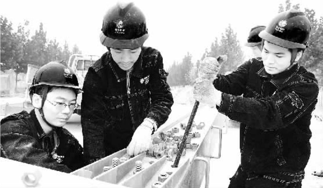
近日,郸城县电业局职工对准郸110kv线路施工,以确保该县的正常供电。(刘兴刚 摄)
