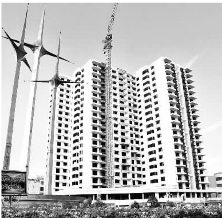
日前,刚刚改造完工的项城市标交通岛在鲜花、高楼大厦的映衬下格外瑰丽壮观。今年下半年,该市相继开展了包括市标交通岛改造工程、中心广场改造工程、莲花仙子改造工程等20个城市建设重点项目。项目陆续完工后,将对市民开放,接受市民检验。(记者 沈湛博)
