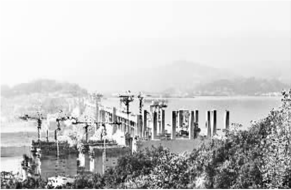
三峡枢纽175米试验性蓄水进入最后“1米冲刺” 这是10月18日拍摄的长江三峡大坝。截至10月18日23时,三峡水库上游水位已达174.18米,三峡枢纽175米试验性蓄水进入最后的“1米冲刺”阶段。按照蓄水调度计划,三峡水库在10月底或11月初完成175米蓄水目标。
