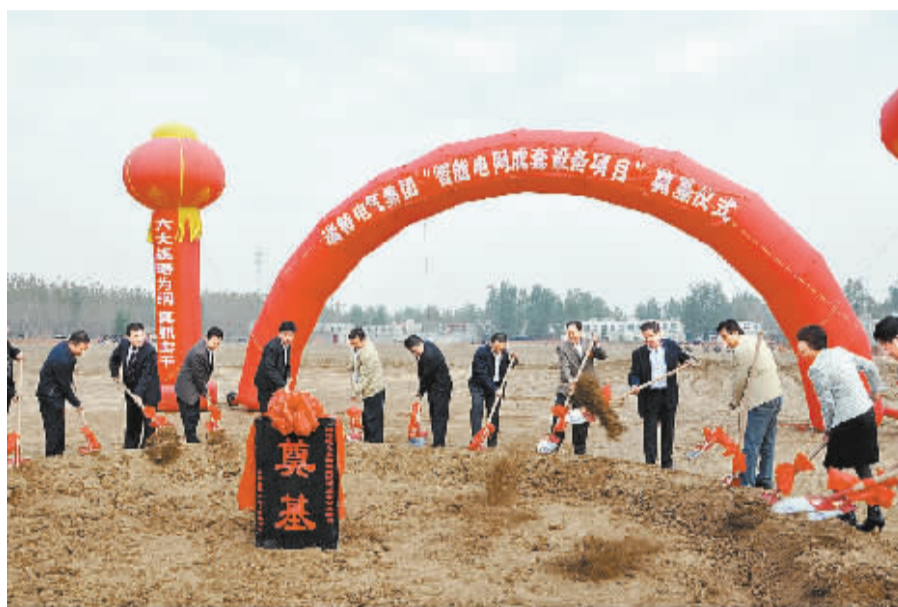
川汇区六大新上工业项目10月20日举行开工仪式,图为市区领导为项目奠基。
