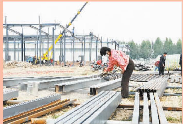
河南丰泽园年产8.5万吨食品项目建成投产后,年产值可达4亿元,年出口创汇5000万美元。图为工人在项目建设工地建设厂房。
