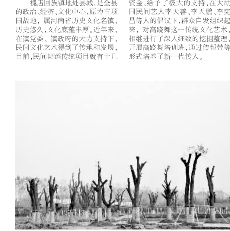
建设中的沈丘中华桃园一景,桃园项目位于沈丘县行政新区北侧,北临南洛高速,是沈丘县委、县政府今年确立的一项重点民生工程,是加快该县城乡建设、推进城市化进程的一项战略举措。该项目今年6月30日开工,一期工程工期计划6个月,目前已完成总体工程的60%以上,年底基本完成主体工程建设。(韦伟 迟驰 摄)
