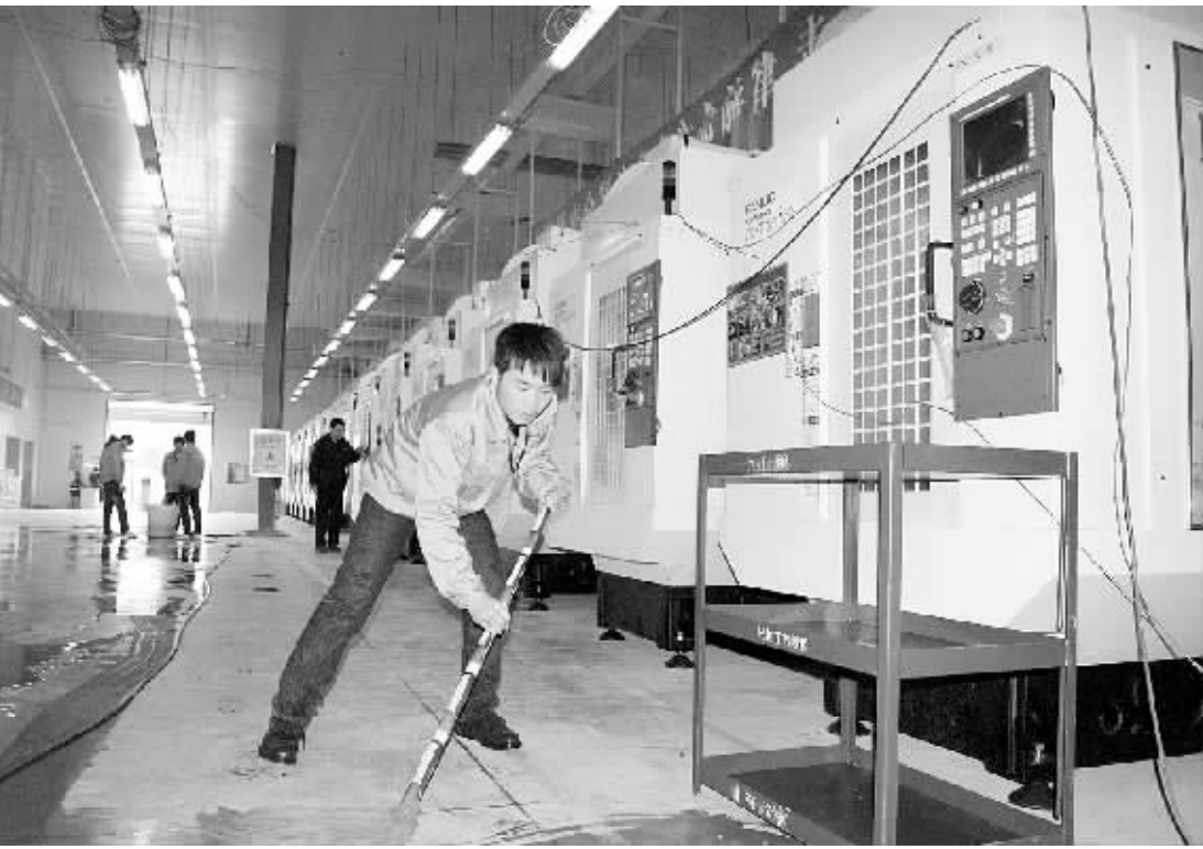
12月8日，西华富士康实训基地10号车间内，员工们正在为投产前做准备工作。据了解，目前，西华富士康实训基地项目的设备已安装调试完毕，预计于近日开工，主要生产苹果手机等知名品牌电子配件。一期全部投产后，年加工电子配件可达300万件。
