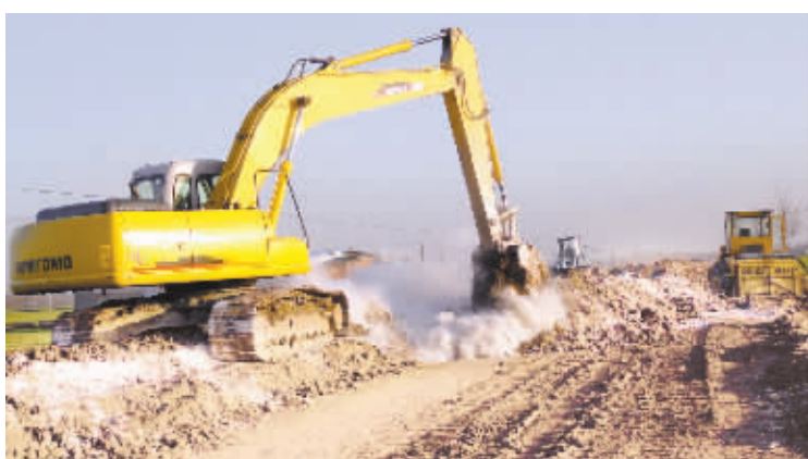
12月12日,商水县白谭公路正在加紧施工中。据悉,白谭公路总长22公里,此次修筑为水泥路面,即将竣工。(乔连军摄)
