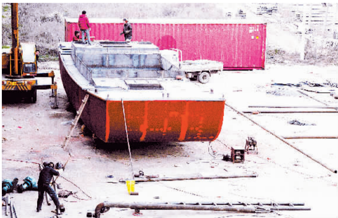
周口沙颍河复航工程实现了内河航运“通江达海”的梦想,也给我市沿河区域带来无限商机。沈丘县周营乡利用刘集村毗邻沙颍河的优势,建造了我省第二大内陆河航运船舶制造基地。一些多年从事航运经营的业主告诉记者,今后不出家门就能从造船基地直接开出新船了。(记者 沈湛 摄)
