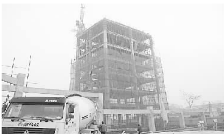
作为项城市委、市政府今年确定的20项重点城市建设项目和“双十五”工程,项城客运西站新建工程于12月22日提前完成了主体工程。 记者 杨光林 摄
