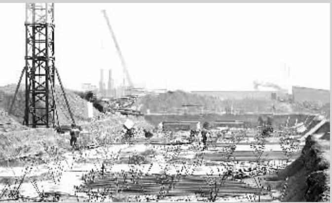
项城市保障性住房——惠民小区掀起施工高潮。
