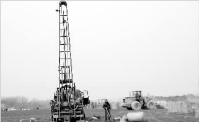
春节过后,2×300MW 等级燃气发电项目奠基仪式准备工作正在紧张进行中。
