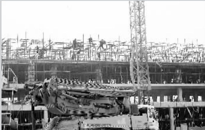
民生工程——团结路小学正在加班加点建设中。
