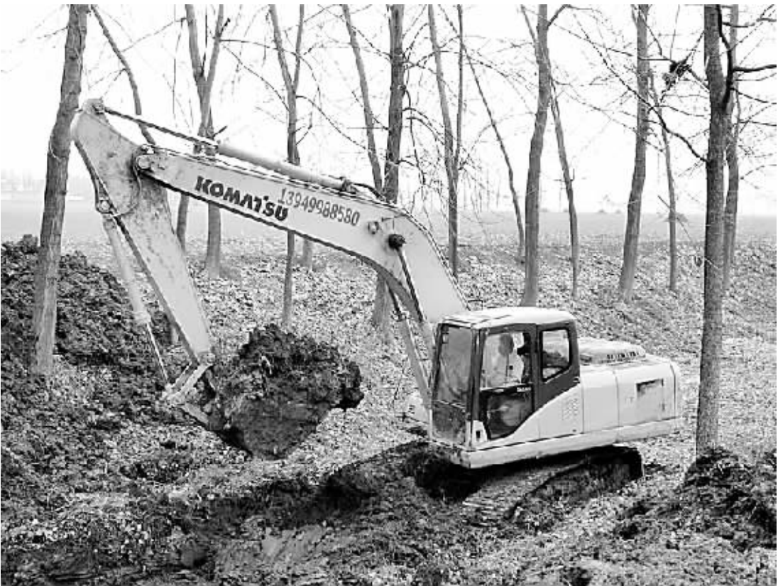
商水县以增强农田旱涝保收能力为目标,以疏通沟渠和廊道为重点,除涝兴利两手抓,田、林、路、沟综合治理,确保今春农田水利基本建设和植树造林工作见成效。图为大型挖掘机在清理沟内淤泥。
