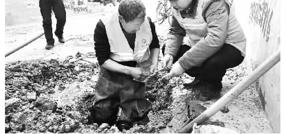
上图:记者在自来水管道维修现场,给师傅帮忙递工具。(记者 王映 摄)
