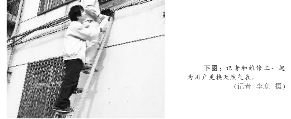
下图:记者和维修工一起为用户更换天然气表。(记者 李寒 摄)
