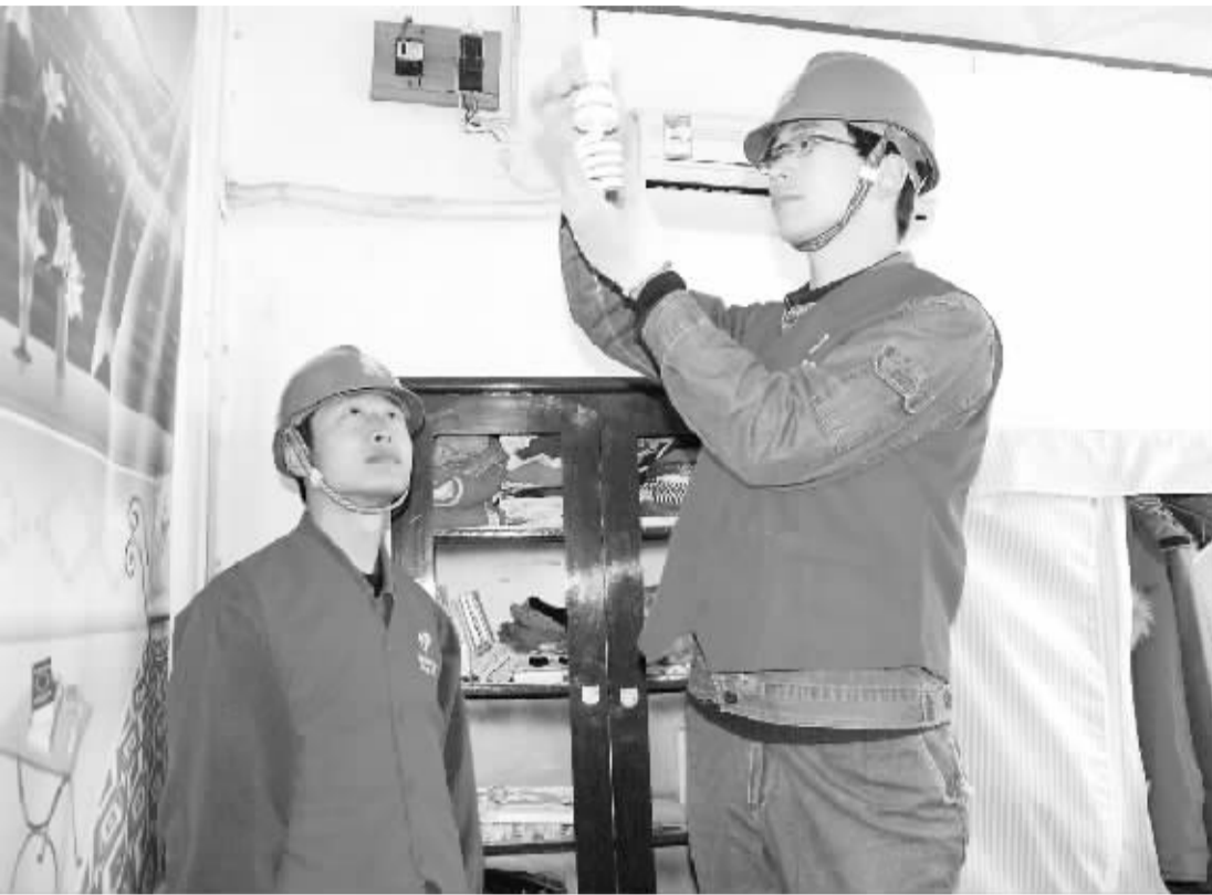
第49个“学雷锋日”来临之际,扶沟县供电公司成立9支“红马甲服务队”,深入学校、社区、企业、农户进行爱心帮扶和安全用电隐患排查,现场解决各种用电问题。图为该公司“学雷锋服务队”成员正在对柴岗乡河坑村张军家里的用电设施进行检查。(刘滨 刘军胜 摄)
