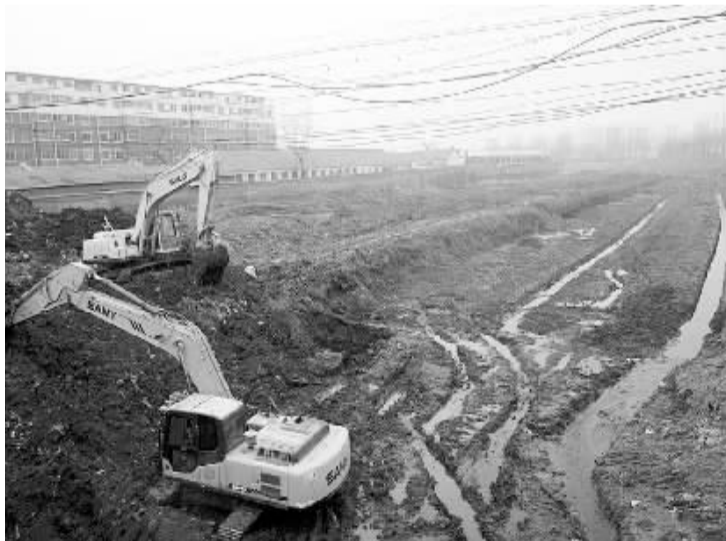
项城市驸马沟改造工程施工现场,施工车辆正在进行清淤净底。改造好的驸马沟,将成为市民休闲的好去处。(赵献伟 摄)
