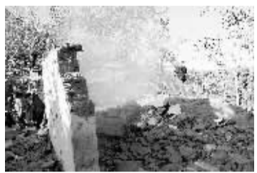
墨西哥南部强烈地震尚无人员伤亡报道 3月20日,在墨西哥格雷罗州奥梅特佩克市,当地居民查看地震中倒塌的房屋。据墨西哥国家地震局测定,当地时间20日12时02分,墨西哥南部格雷罗州发生7.8级地震。新华社发
