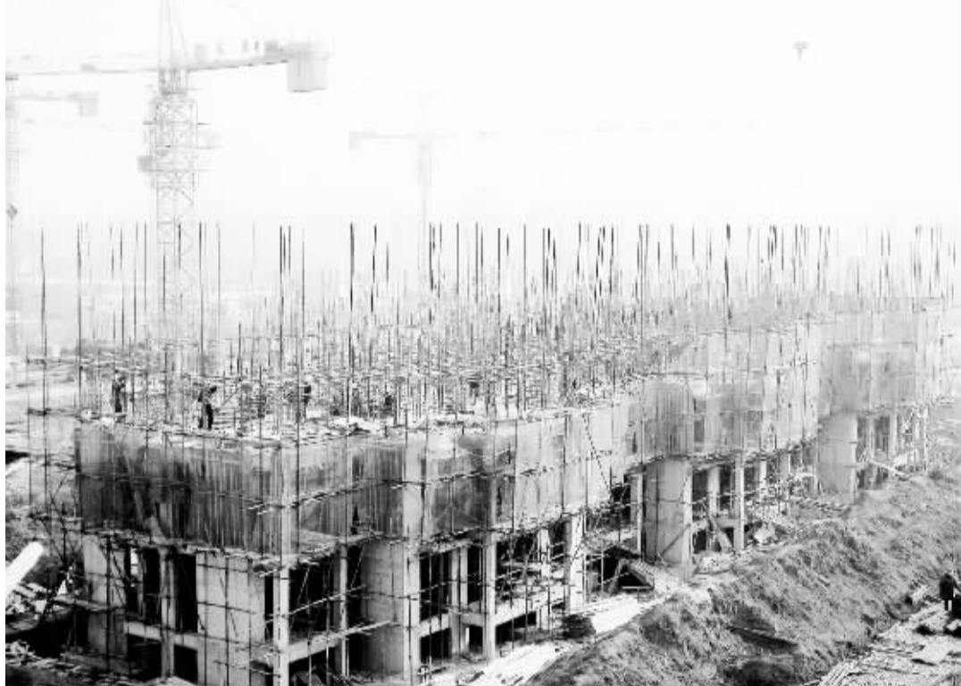
3月27日,项城市保障性安居工程——惠民小区的施工现场一片繁忙,几百名工人正在抓紧施工。该项目作为项城市规模最大的安居工程,总投资1.6亿元,预计今年12月底竣工。 记者 金月全 摄
