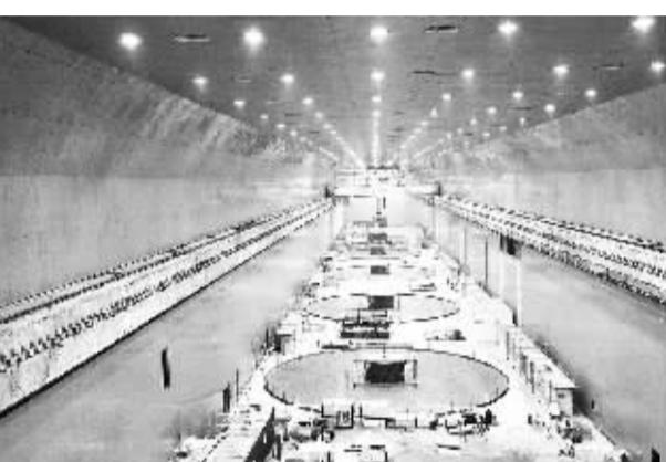
三峡地下电站全部机组投产进入最后冲刺阶段。4月9日拍摄的三峡地下电站全景图。在建的三峡地下电站位于右岸大坝山体内,设计安装6台单机容量为70万千瓦的混流式水轮发电机组,其中5台已投产发电。新华社发
