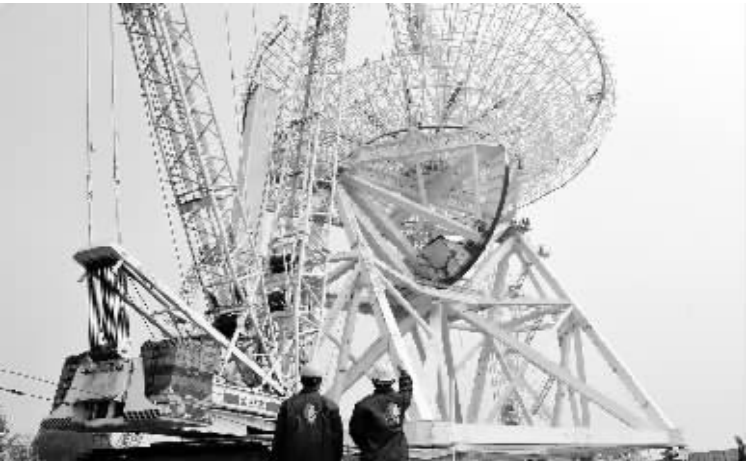
上海 65 米射电望远镜完成天线吊装雄姿初现 工程技术人员正在进行上海 65 米射电望远镜天线吊装(4 月 17 日摄)。当日,高 70 米、重 2600 多吨的上海 65 米射电望远镜圆满完成天线吊装,预计今年内基本建成。届时,上海金山脚下,将竖起一只巨大“耳朵”,能清楚地听到来自宇宙深处微弱的射电信号,观测到 100 多亿光年外的天体。
