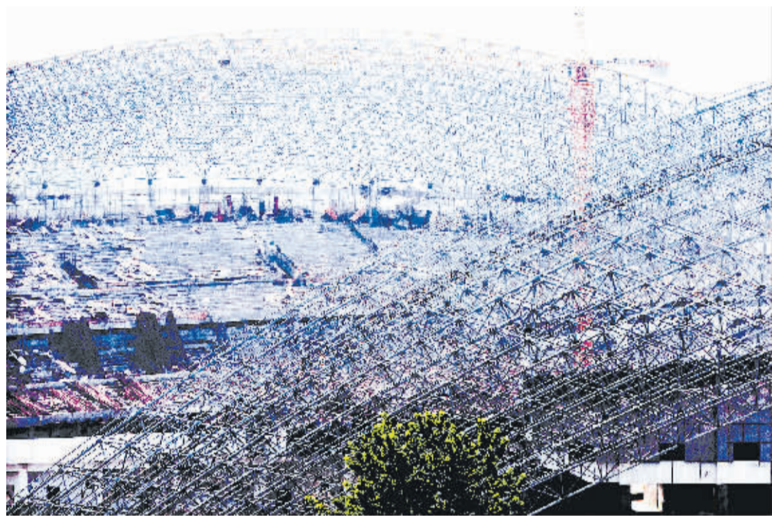
周口体育场东西两侧的框架钢结构日前成功合龙。如今,雄伟壮观的体育场轮廓初现。市体育场建成后,能够承办国际、国内足球、田径等体育赛事,也将成为我市大型文体表演的理想场所。(记者 沈湛 摄)
