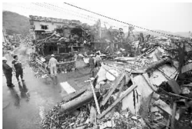
龙卷风袭击日本关东地区 5月6日,在日本茨城县筑波市,人们在因龙卷风袭击而受损的房屋旁。日本茨城县等关东地区6日下午遭受龙卷风袭击,多地房屋受损严重,数十人受伤。新华社发
