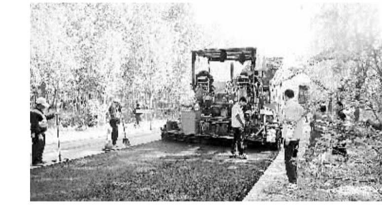
近来,淮阳县公路局组织施工工人100多名,出动挖掘机、压路机、摊铺机等设备10余台,维修拓宽路淮阳段。目前,已挖补1.3万平方米,罩面近4万平方米。(侯俊豫 史金力 摄)
