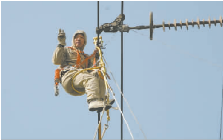
带电作业确保供电
