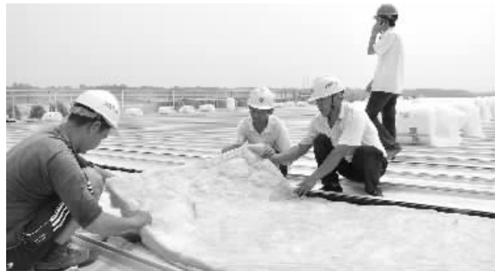
在河南久通电缆公司厂房主钢结构顶部，工人们正在铺设隔热棉和顶棚钢板。 该项目总投资 30000 万元，已完成投资 5500 万元。（李寒 樊葩茵 摄）
