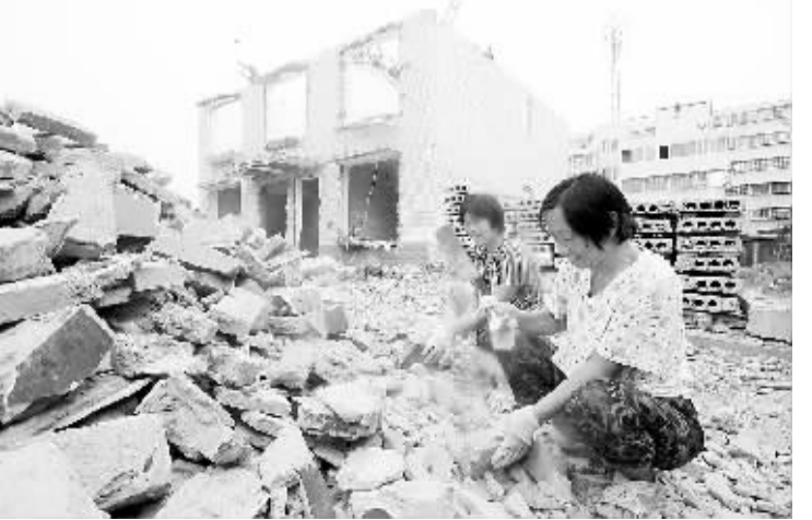
昨日上午,在文昌大道丹尼斯城市综合体项目工地,几名工人正在对已经签订协议的居民房屋进行拆除。今年以来,文昌大道拆迁、安置房建设等工作加大力度,取得了显著成效。轴统厂厂房、地税局印刷厂房屋全部拆除,拆迁面积近30000平方米。(记者 李寒 摄)
