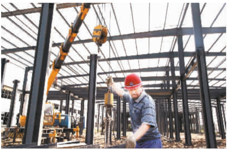
9 月 4 日, 在商水县成大大鞋业有限公司项目建设现场, 施工人员正在加紧施工。该项目总投资 4 亿元, 专业生产外销欧美登山鞋、休闲鞋, 项目达产后年产值近 10 亿元。(刘飞 魏红 摄)
