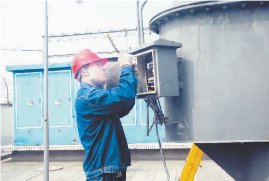
近日,扶沟县供电公司组织技术人员对网架内变压器进行统一调配,使之运行合理、供电有序,为电网安全运行、可靠供电奠定基础。图为该公司修试工区在韭园35kV变电站为调配后的新主变接二次电缆。(刘滨 刘军胜 摄)
