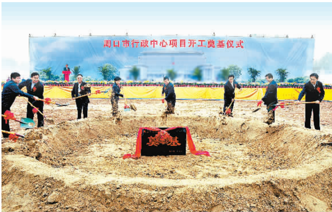
图为奠基现场。(记者 沈湛 摄)
