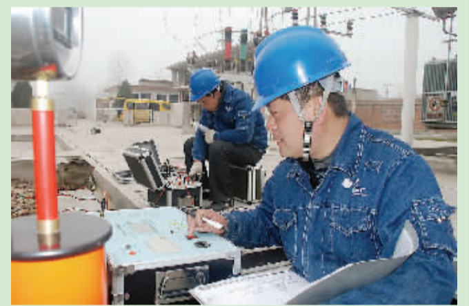
工程技术人员正在进行紧张的现场作业
